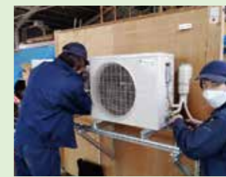
エアコン実習
