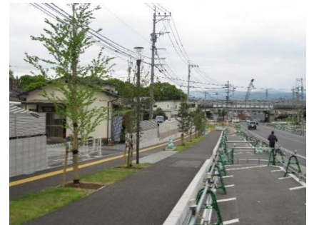
（都）益城中央線 植栽状況
