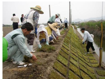
法面の管理の様子
