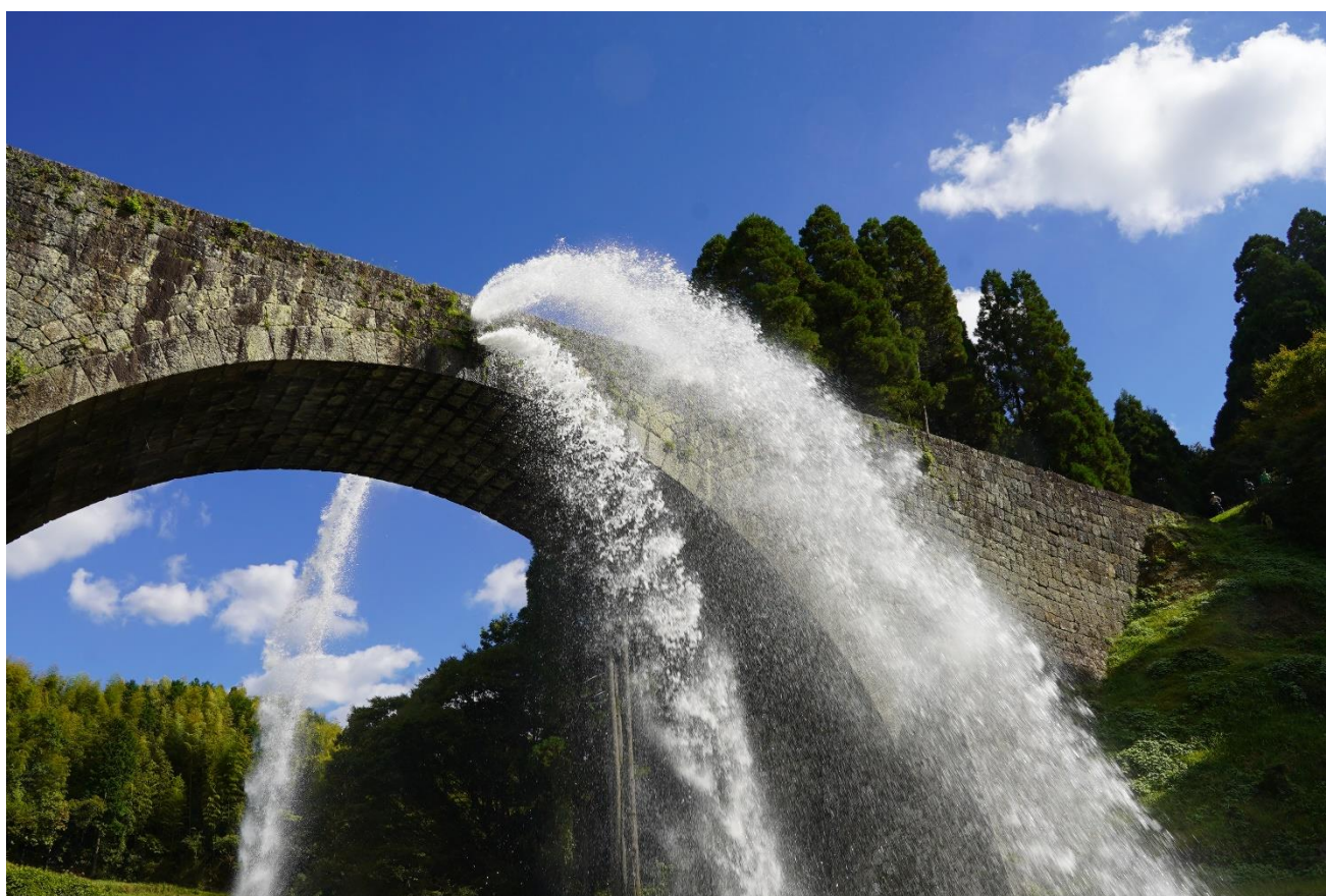
通潤橋(山都町)
