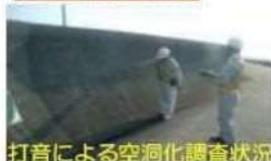
打音による空洞化調査状況
