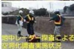
地中レーダー探査による空洞化調査実施状況
