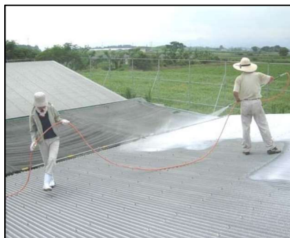
屋根上部への消石灰の塗布
