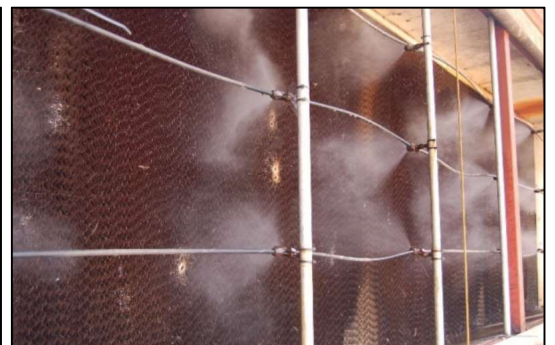
クーリングパッドの設置
