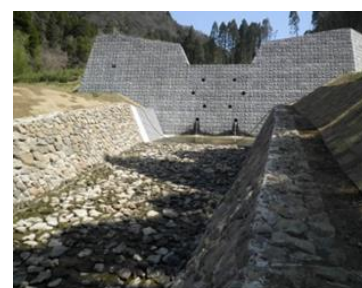
自然石利用護岸工
