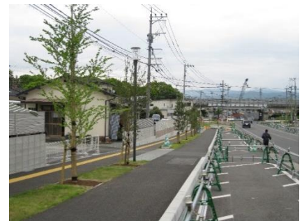
（都）益城中央線 植栽状況
