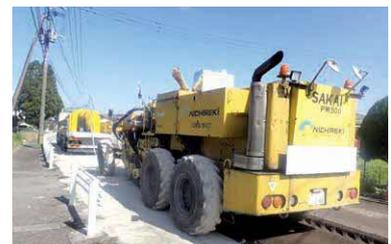
現場で舗装発生材を破砕し、同時にアスファルト乳剤とセメントを混合します。
