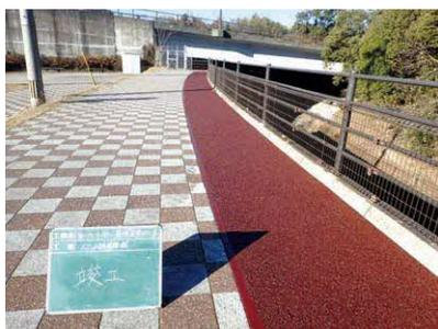
木質系舗装の「アスウッド工法」は間伐材や災害で発生した流木を使用。
