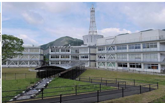
▲ 震災遺構 (南阿蘇村 旧東海大学阿蘇校舎1号館) 【出典：熊本地震デジタルアーカイブ/提供者：熊本県】
