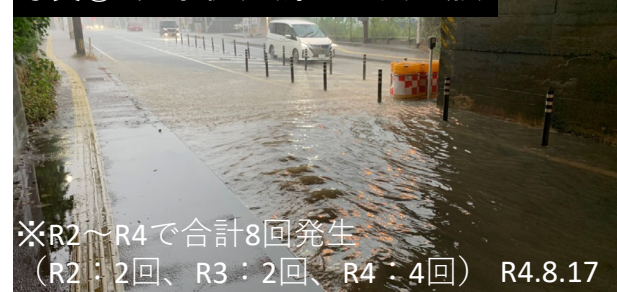
写真③ 冠水状況(原万田交差点)
