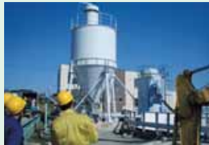
焼却灰のばいじんに汚泥とセメントを混ぜ合わせ固化する施設の整備
