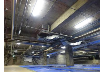
議会棟地下倉庫(R4施行)
