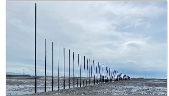
漂流物対策フェンス (白川河口域 令和4年7月撮影)
