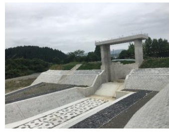
写真 1.92 御溝川整備状況 (2次放水路)
