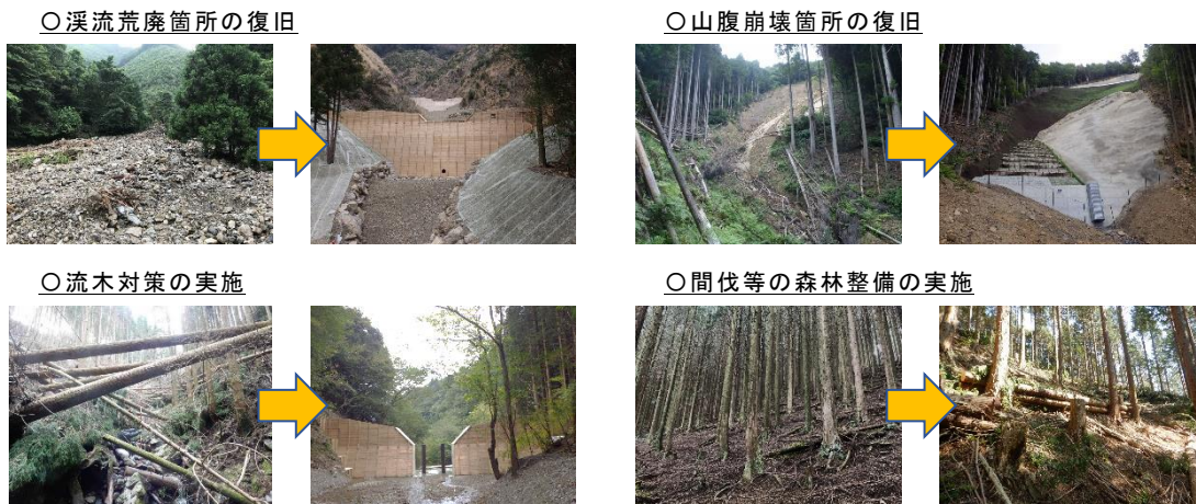
写真 5.3 治山事業による土砂・流木対策の例
