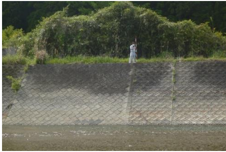
写真 5.12 河川点検・巡視の状況
