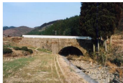
写真 1.86 大正橋(あさぎり町)
