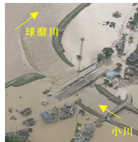
令和 2 年 7 月豪雨による小川・小川橋の浸水状況(球磨村)
