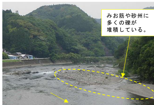
写真 5.7 川辺川の礫堆積状況
