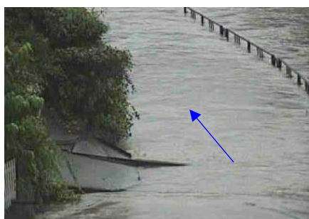
写真 2.4 御溝川浸水状況 (人吉市)
