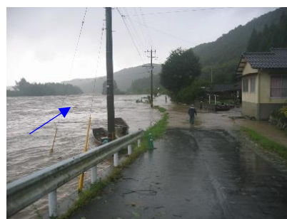
写真 2.5 川辺川浸水状況 (相良村)
