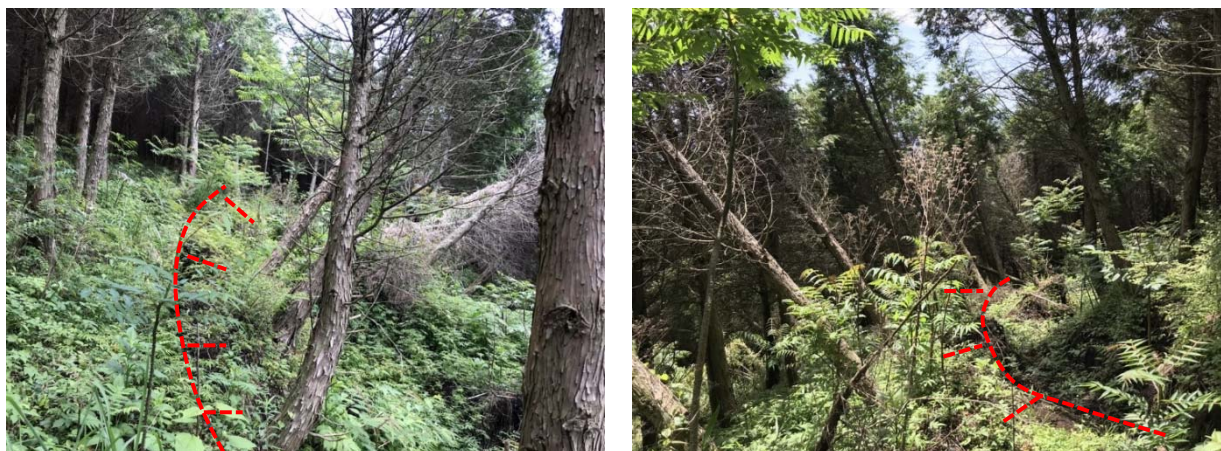
写真 5.1 樹木による亀裂の拡大
