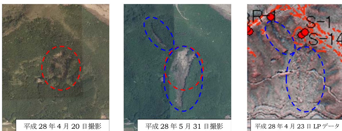
図 5.5 「三ツ石地区」の時系列の崩壊状況
