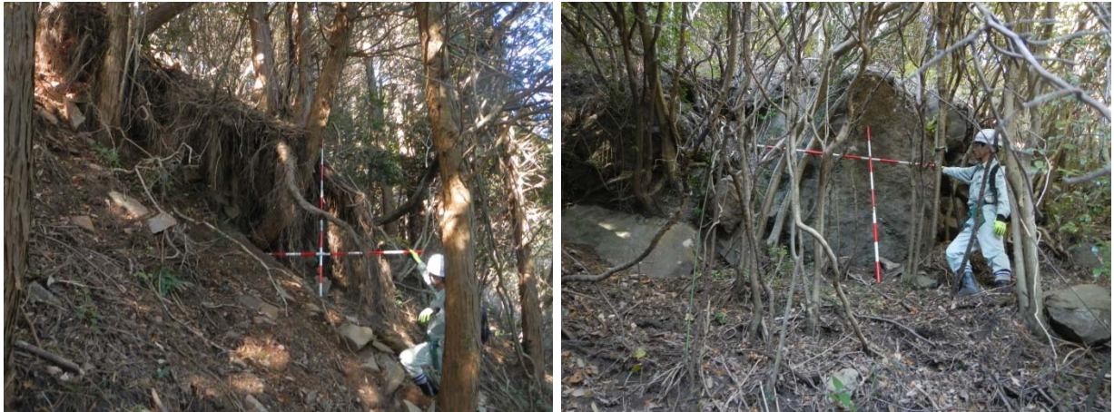
写真 4.3 モニタリング亀裂 S-3 周辺のはらみだしの状況
