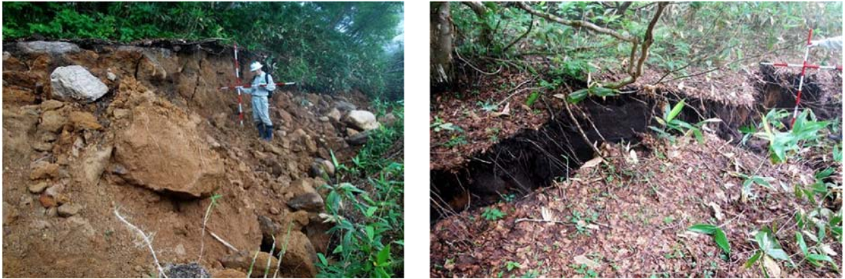
写真 4.2 産女川溪岸で確認された山腹崩壊および亀裂（[左] 段差地形、[右] 開口亀裂）
