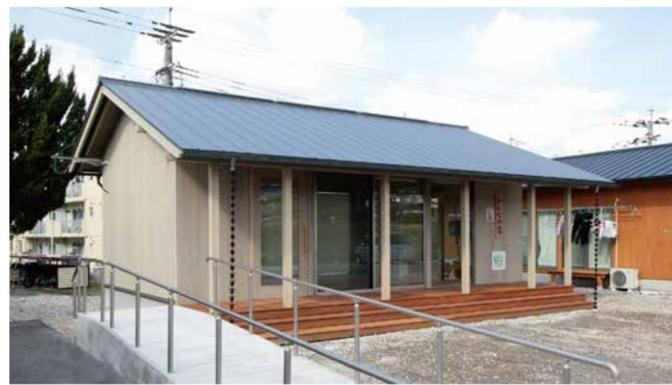
敷地は、仮設住宅の住棟間に位置している。住戸のプライバシーに配慮し、南と北の住戸間には妻壁を設け視線を閉じ、南と北の住戸間には開口を設けている。切り妻の大きな屋根を広場側に置き下る。応急仮設住宅の住棟間の広場と一体的なつながりをつづけている。広場に面して半外部のテラス、大きな階段を設け、内と外とが一体的につながっている。東西に開く中央のワンルーム空間に面してキッチン、トイレ、収納を配している。構造計画としては、第2仮設と同様に105角の材料を基本とした架構とし、ローコスト化を図っている。また、隣接する境目地災害公営住宅の集会所のデザインにも基本システムを展開し、地域への面的な広がりを目指している。
