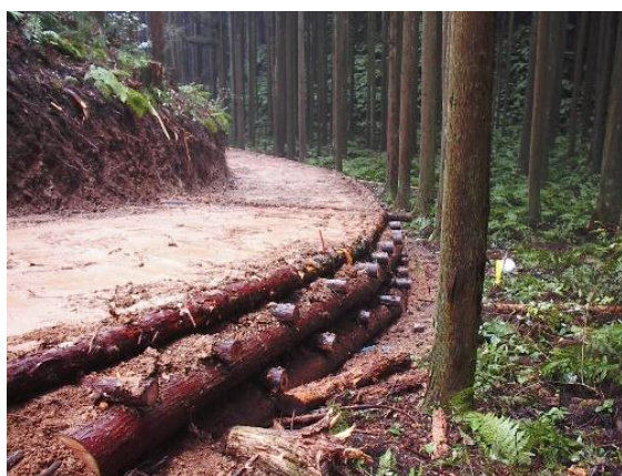
丸太組構造物を使用した道づくり
