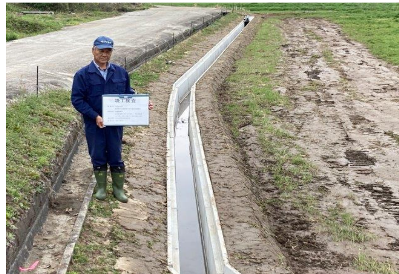
更新された排水路
