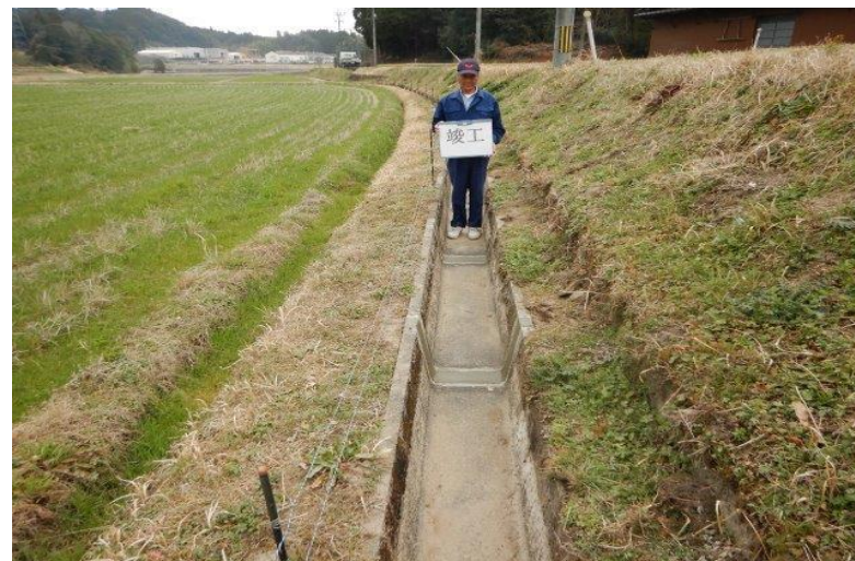
改修を終えた用水路
