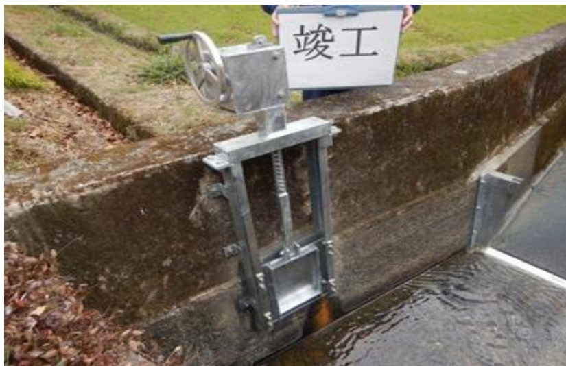
補修された堰
