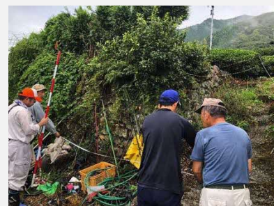
H30.8.30 広平地区現地検討状況
