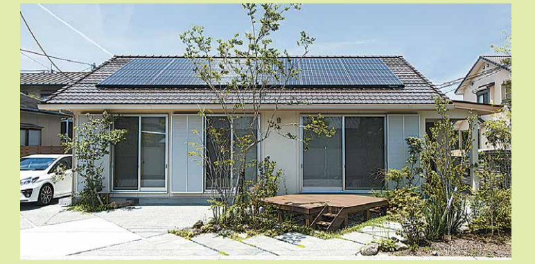
太陽光パネルで電力を自給
