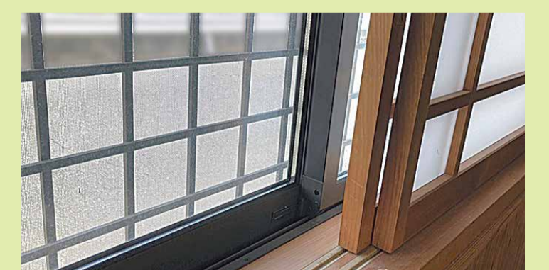
二重窓と内窓で冷暖房の設定温度を抑える
