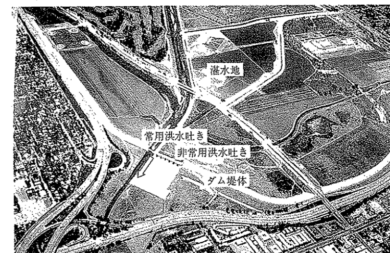
写真-19 Sepulveda ダム (1941 年完成)
