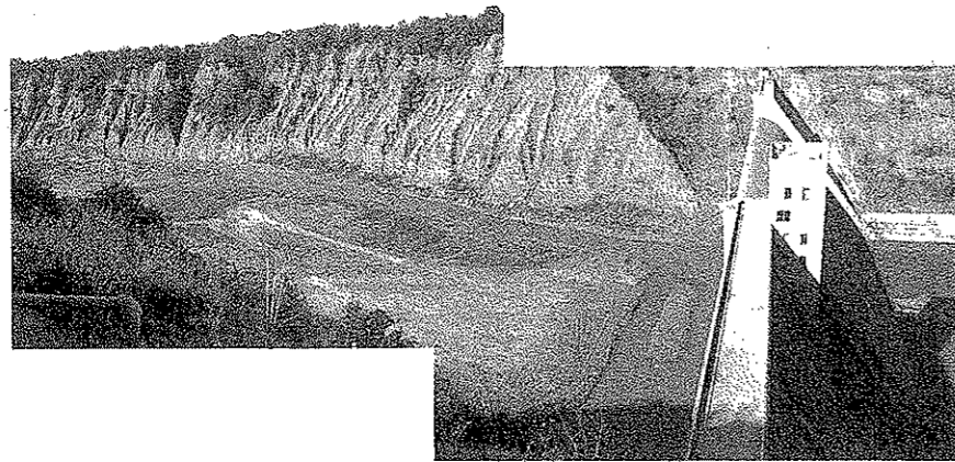
写真-12 貯水池内の状況 (Mount Morris ダム)
