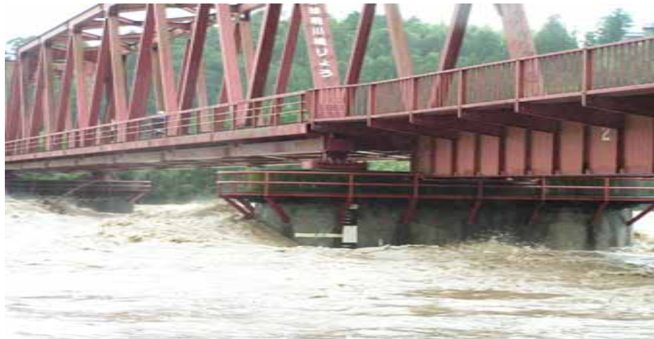
球磨川第3橋梁を望む【人吉市】
