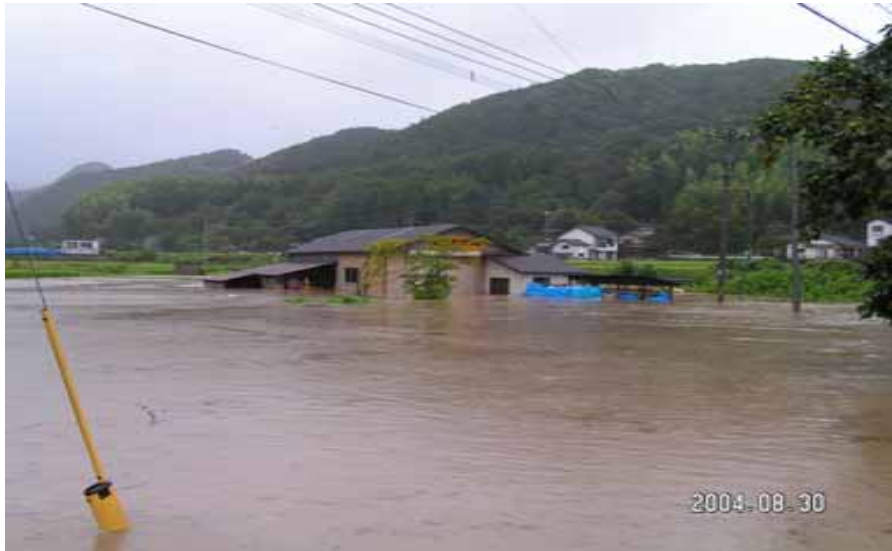
小川右岸浸水被害(小川橋付近) [ 球磨村 ]
