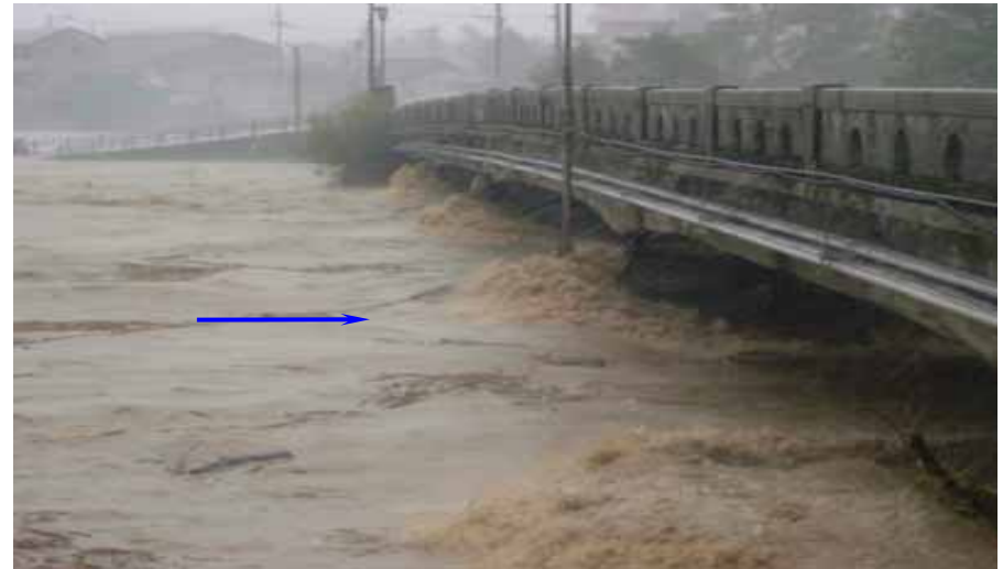
右岸側より人吉大橋桁下を望む [ 人吉市 ]
