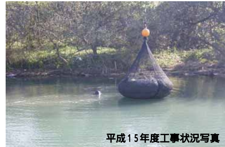
平成15年度工事状況写真
