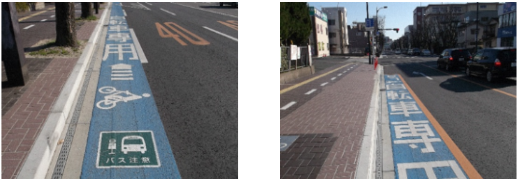
図表 41-1 熊本市中央区大江地区に整備された自転車専用通行帯、自転車の交差点進入禁止に係る道路標識・標示
