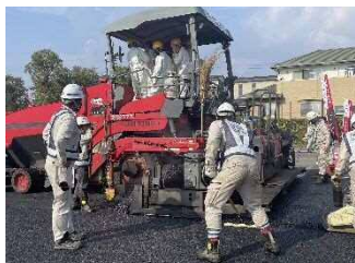
写真-5 舗装実習
