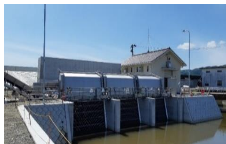
<豊川中央排水機場（R3.7 月供用開始）>
