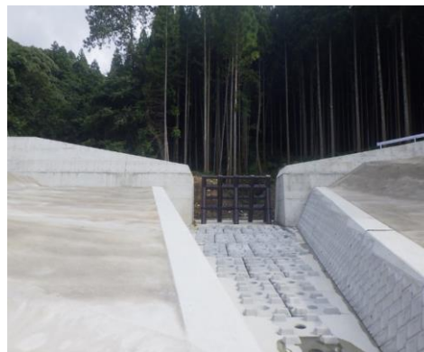
<竣工：堰堤工 (R3.10月)>
