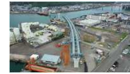
本渡道路整備状況(R3年5月撮影)
