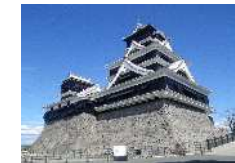
復旧した熊本城天守閣(熊本市提供)
