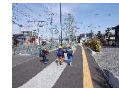
県道熊本高森線：完成した歩道を歩く小学生たち
