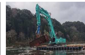
くま川鉄道の復旧(橋桁撤去)
