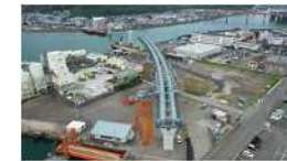
本渡道路整備状況(R3年5月撮影)
