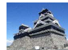
復旧した熊本城天守閣(熊本市提供)
