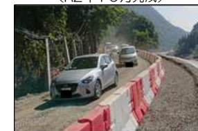
国道219号啓開完了(球磨村渡)
