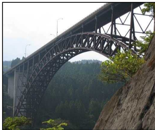
【アーチ橋】奥阿蘇大橋
