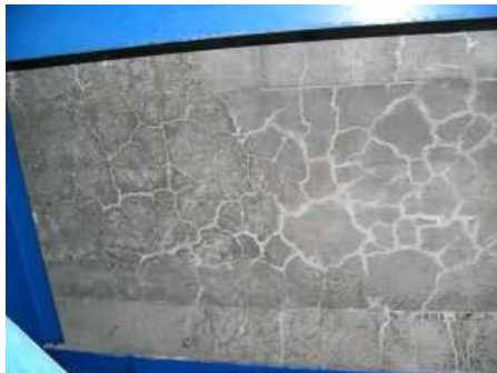
床版下面状況
