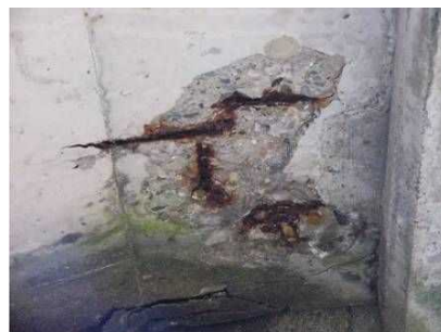
鉄筋腐食による損傷：剥離・鉄筋露出
