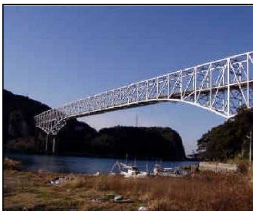
【トラス橋】天門橋
