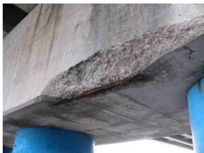
車両衝突による損傷：変形・欠損
