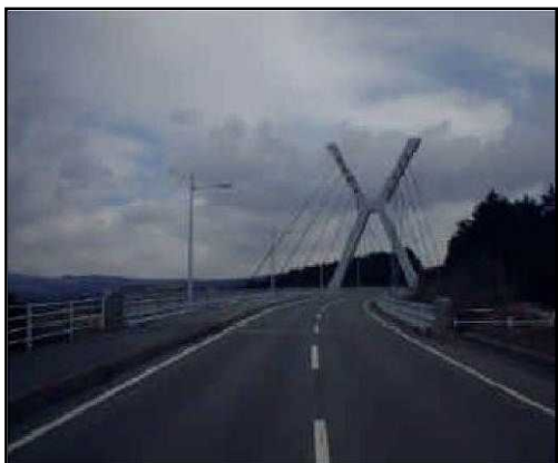
【斜張橋】桑鶴大橋
