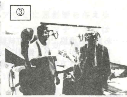
③ 作業の流れを打ち合わせ中。
