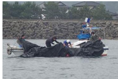
シート敷設作業
