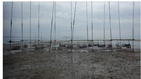
図 2 支柱養殖施設全景
