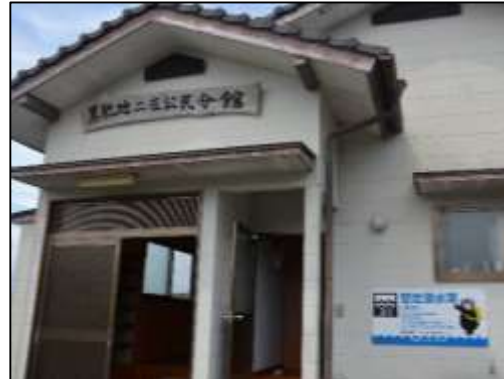
設置状況(多良木町)
