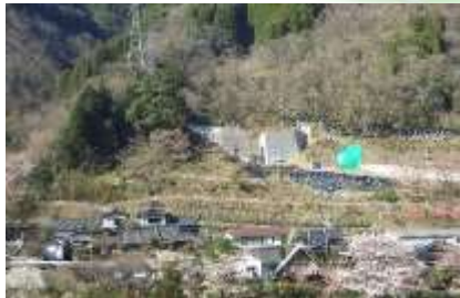
保全対象直上に砂防堰堤を整備
