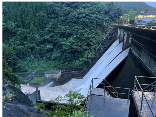
非常用洪水吐からの越流状況 (8月13日午前5時頃)
