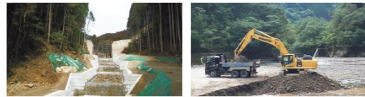
北目川砂防堤防(水上村) 万江川砂防堰堤1での土砂撤去(山江村)
