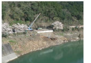
国道219号の復旧状況(八代市坂本町)
