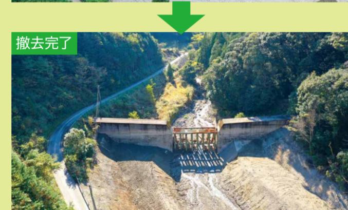
砂防堰堤の堆積土砂撤去(牧良川・湯前町)
