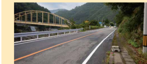
国道219号大野大橋付近(球磨村)
