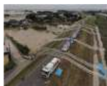
排水ポンプ車の排水状況事例
