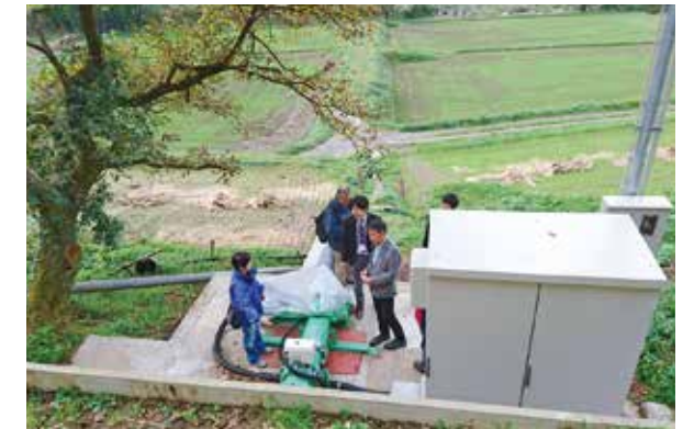
小水力発電所
