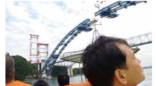
建設中の新一号橋を船上から
