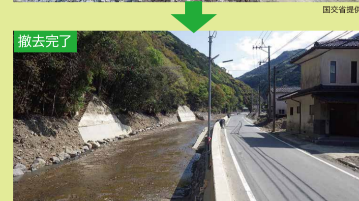
堆積土砂撤去(川内川・球磨村)
