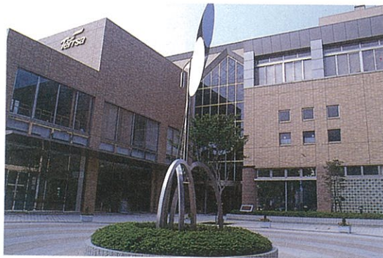
中穏色のタイルを混ぜ貼りした建物の例
