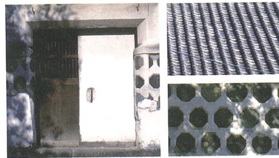
■ 写真 熊本市川尻地区の典型的な外装材
