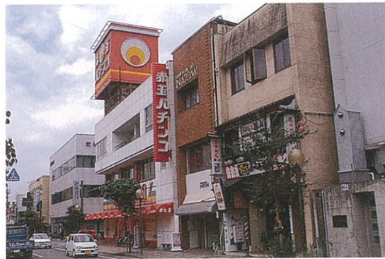
中高層部に設けられた屋上広告や袖看板などのアクセント色
