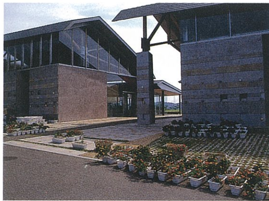
地域で産出される合津石を用いたビジターセンター—上天草市
