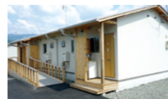
木造仮設住宅
