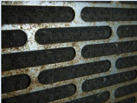
例) 吸入口の目詰まり状況
