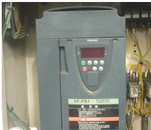
インバータ制御盤
