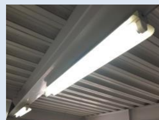
清掃後の照明設備
