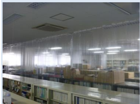
例) ビニールカーテンによる区画設定
