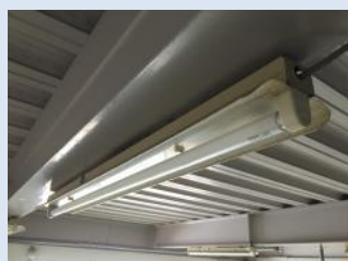
汚れが付着した照明設備
