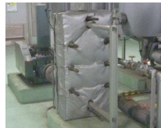
プレート式熱交換器に装着された保温ジャケット
