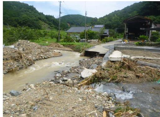
写真一 護岸が決壊した河川
