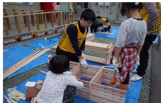
家具の製作・設置
