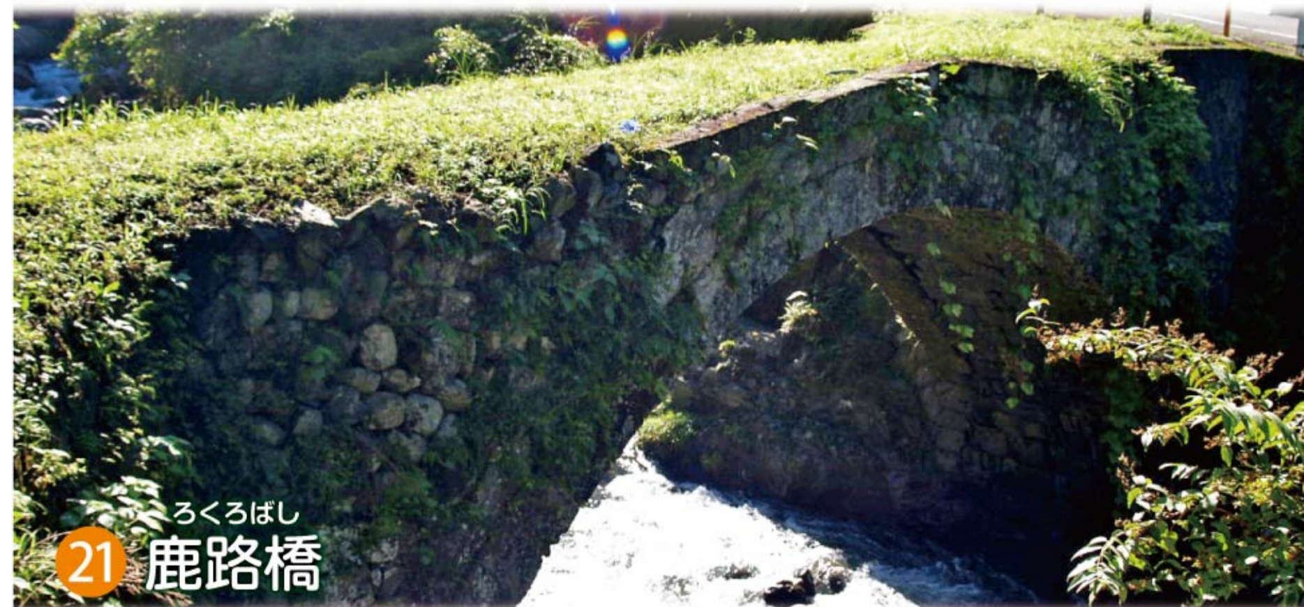
ろくるばし 21 鹿路橋 所在地：八代市東陽町河俣字鹿路 市指定有形文化財。 嘉永元年(1848年)橋本勘五郎の父である、嘉八によって架橋。 鹿路橋の20mほど下流の新鹿路橋が架設されてから傷みがひどくなり、通行止めになっています。
