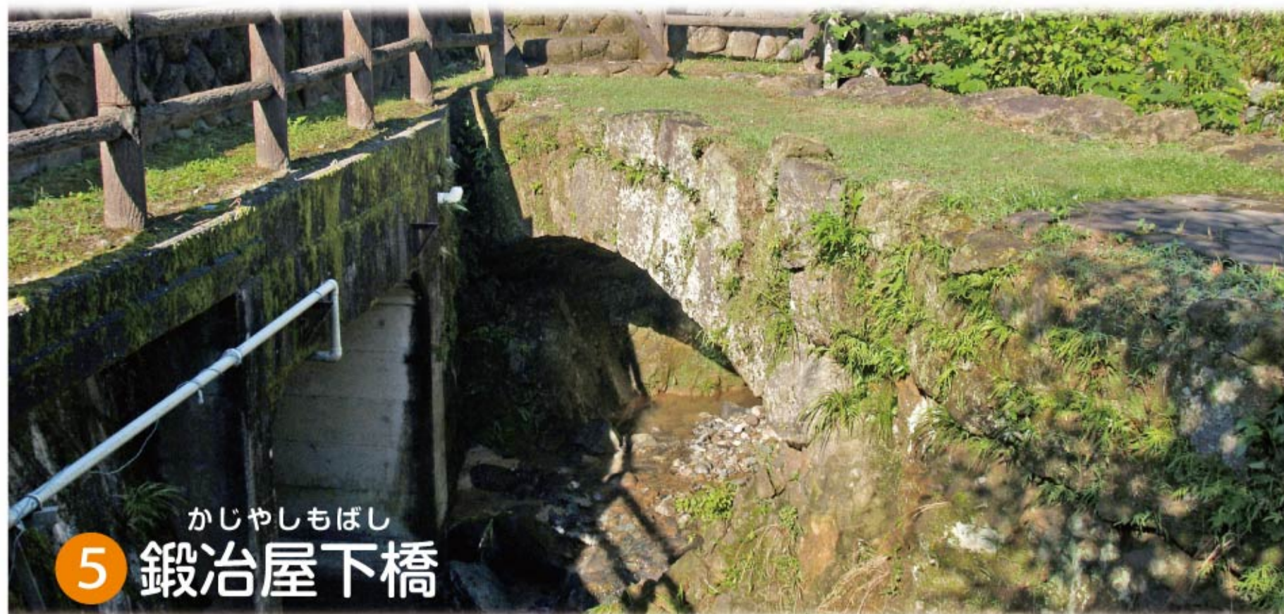
かじやしちもばし 5 鍛冶屋下橋 所在地：八代市東陽町北字西原 市指定有形文化財。 藤原林七が高度な技術に挑戦した最高傑作。 これを完成したことにより、アーチ型の目鑑橋の技術が確立しました。
