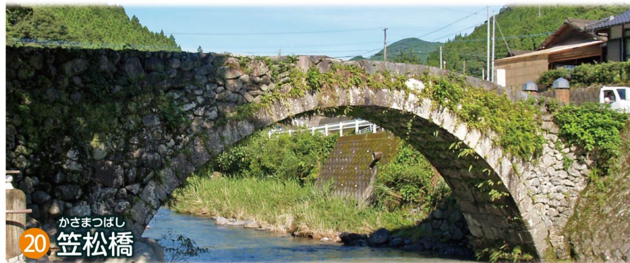
かさまつばし 20 笠松橋 所在地：八代市東陽町河俣字久木野 市指定有形文化財。 明治2年(1869年)橋本文八(翌年、橋本勘五郎となる)によって架橋。 平成12年3月には周囲が公園化され、トイレやベンチも整備されました。夜間にはライトアップされ、石橋の美しい曲線が浮かびあがります。
