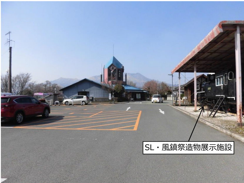
写真3 高森駅舎(現存)を南側方向から撮影
