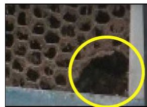
金網等の破損箇所修繕
