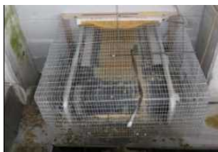
開口部の隙間対策
