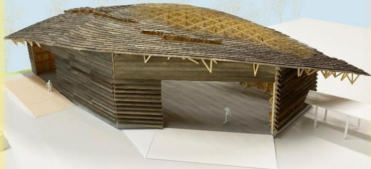
建築概要／木造レシプロカル構造、延べ面積約600㎡
