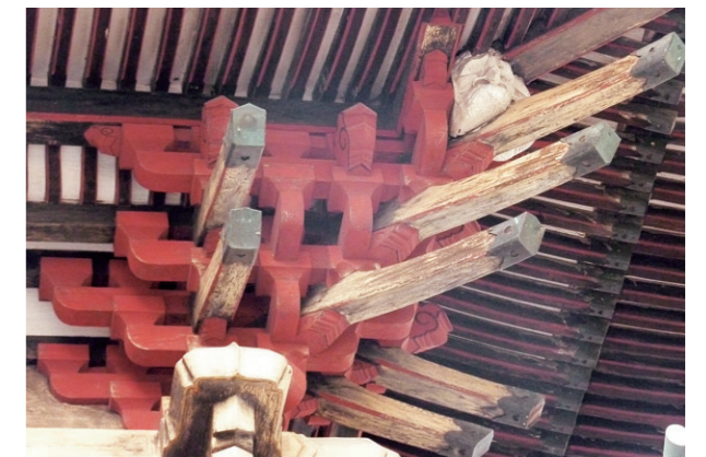
▲人吉様式(屋根下の四隅に8つの神面が取り付けられたもの)
